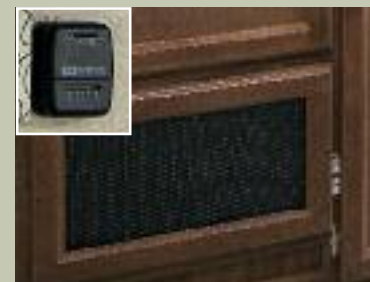
Fournaise canalisée de 20 000 BTU
