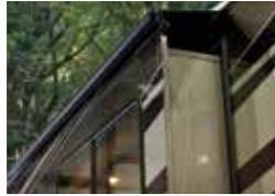
Murs latéraux construits en aluminium de 2" d'épais, avec fibre de verre colorée lustrée.
